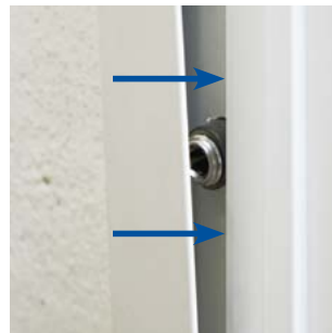
profilo a scatto per la copertura delle viti di fissaggio
