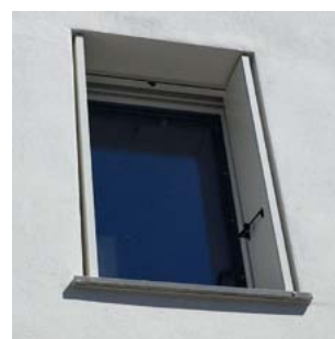
Particolare di PIEGA in apertura
